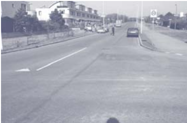
Figuur 12. In Loosduinen (Hoek van Hollandlaan) ontbreekt een poortconstructie.
