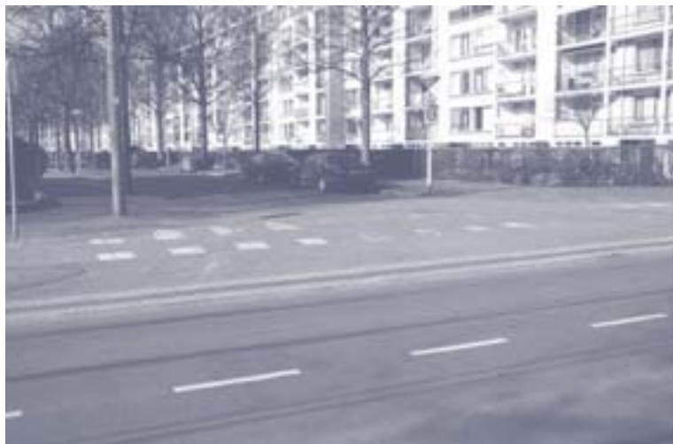
Figuur 10. Poortconstructie, Morgenstond.
